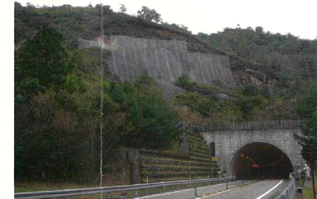
終点側より法面の全景を撮影
